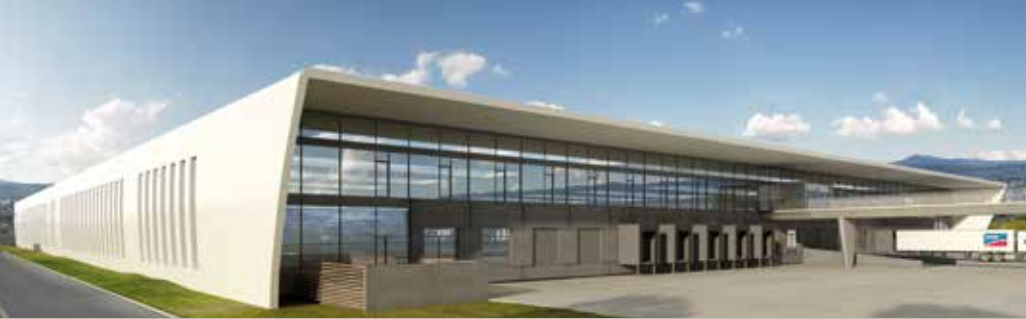
SMA Service Center, Preisträger Holzbaupreis Hessen 2011
